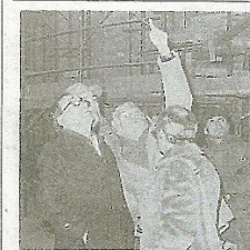
Lavori Strehler nel cantiere che diventerà il Teatro Studio (anni 80), una delle tre sedi del sistema Piccolo Teatro
